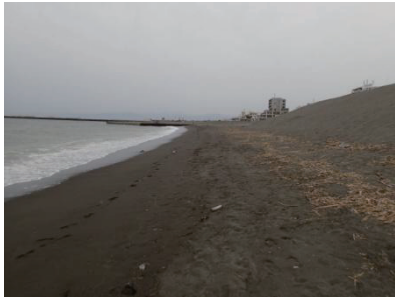
図 4 中海岸地区海岸部の状況 1
